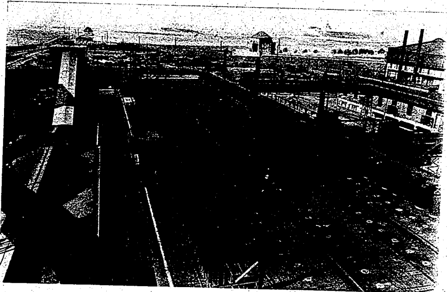
Abb. 20. Kokerei der Ilseder Hütte, Großsiede bei Peine. — 62 Koppers-Verbund-Kreisstromöfen.
