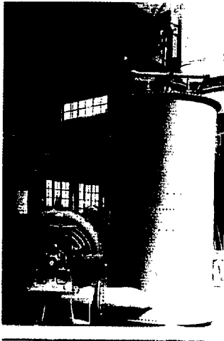
Abb. 93. Eintelliger Desintegrator mit Beruhigungskammer (Zschokke).
