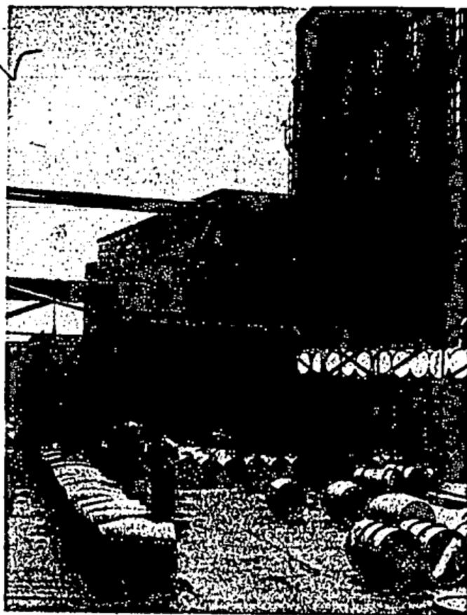
Für den Versand der fertigen Oele sind Tankkähne, Kesselwagen, Eisen- und Holzfässer verfügbar. Ueber 100 eigene Kesselwagen, deren Befüllung zwei Verladestationen mit eingebauten Waggonwaagen dienen, sind in den Versandbetrieb der Firma eingestellt.
